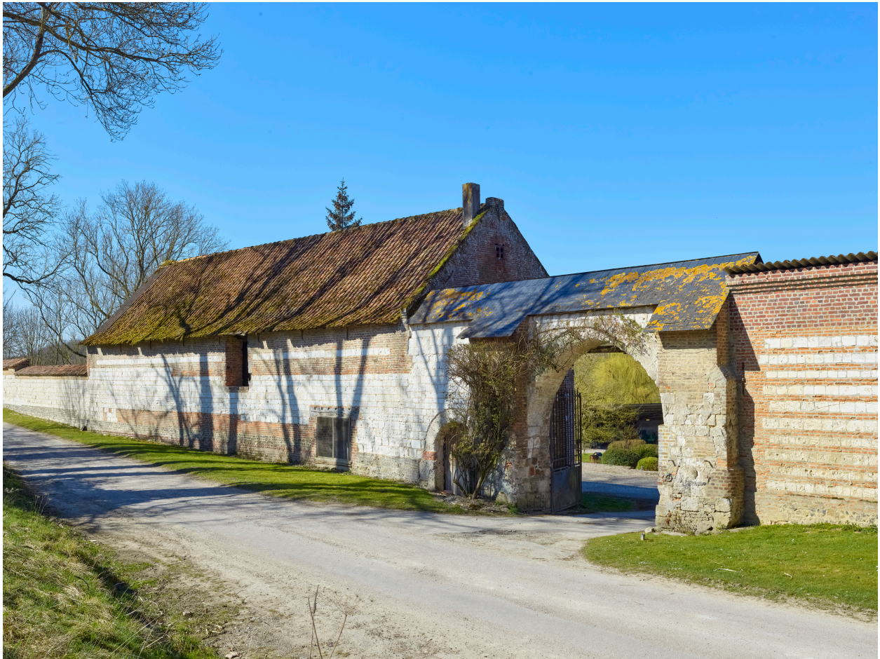
Entrée de la ferme et grange depuis le nord-est.
