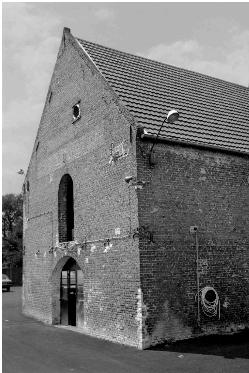
Atelier de fabrication, flanc est.
