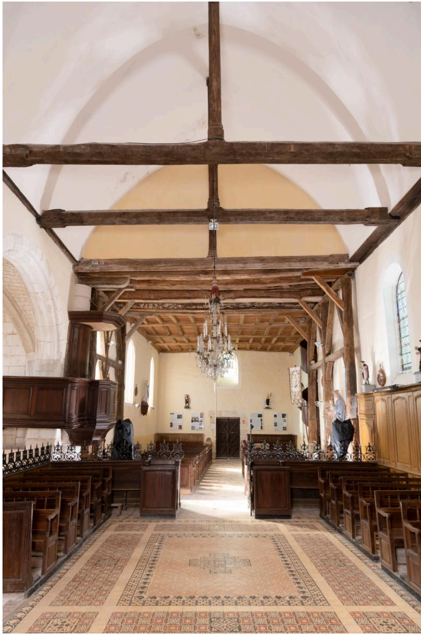
Vue intérieure vers la nef.
