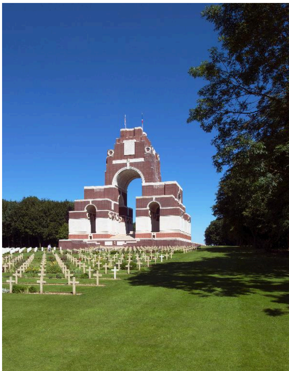
Vue du monument depuis le nord-est.
