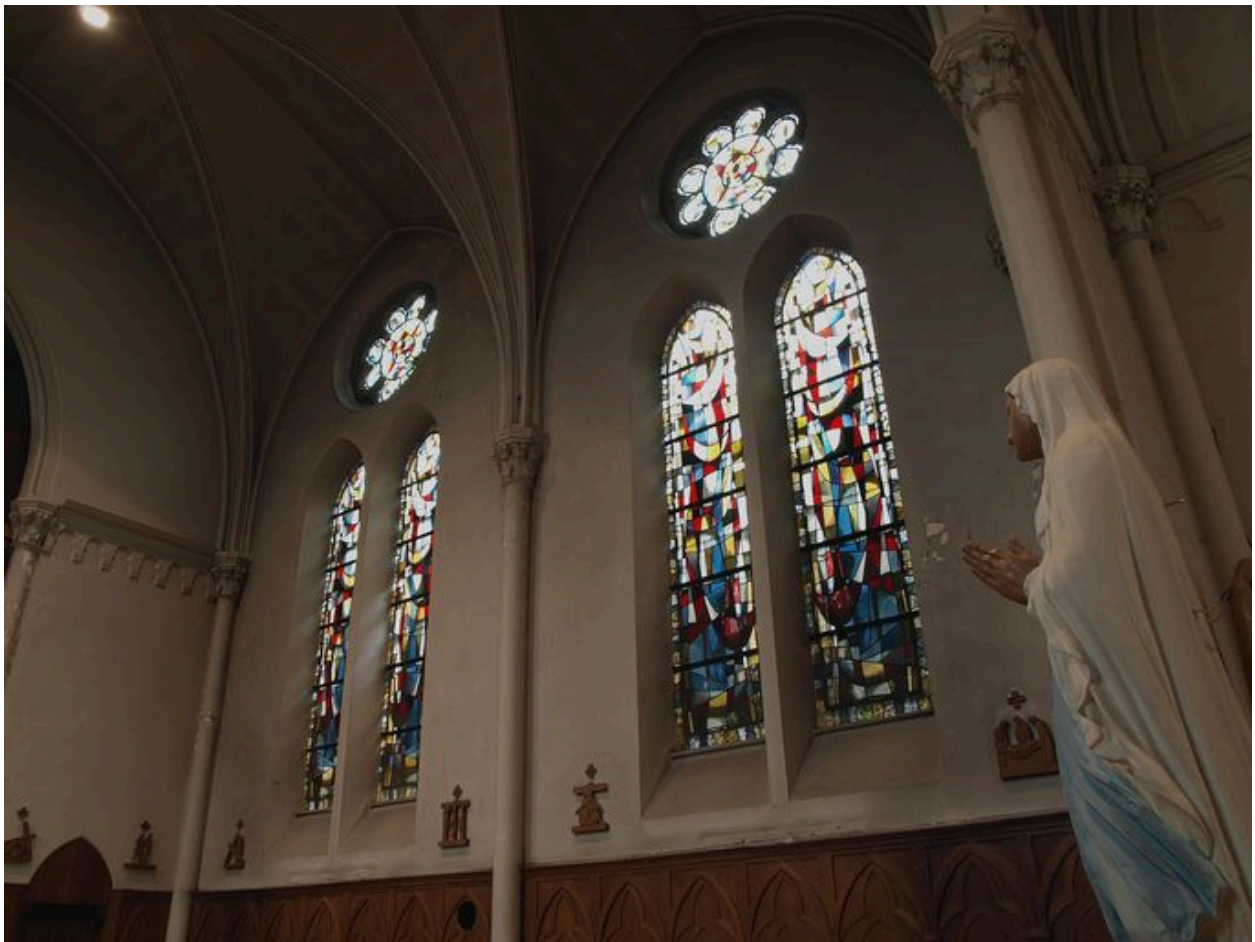
Mur droit du ch#oeur
