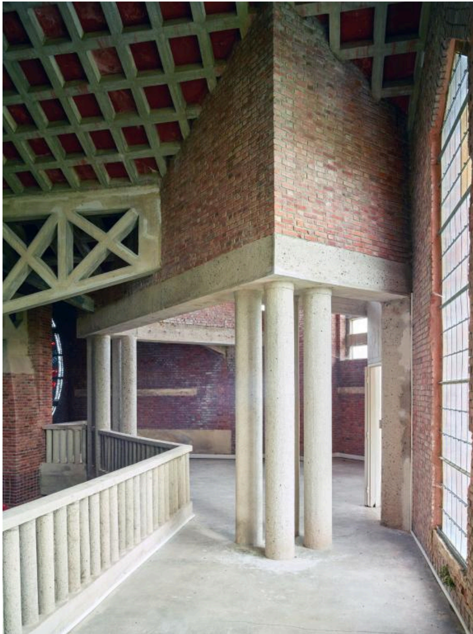
Élément de charpente depuis la tribune.
