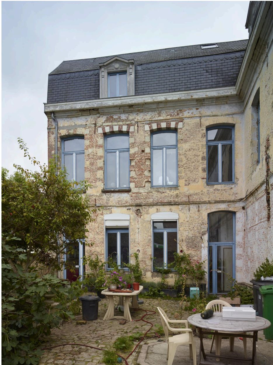
Ancienne école privée : façade arrière de l'aile en retour d'équerre.
