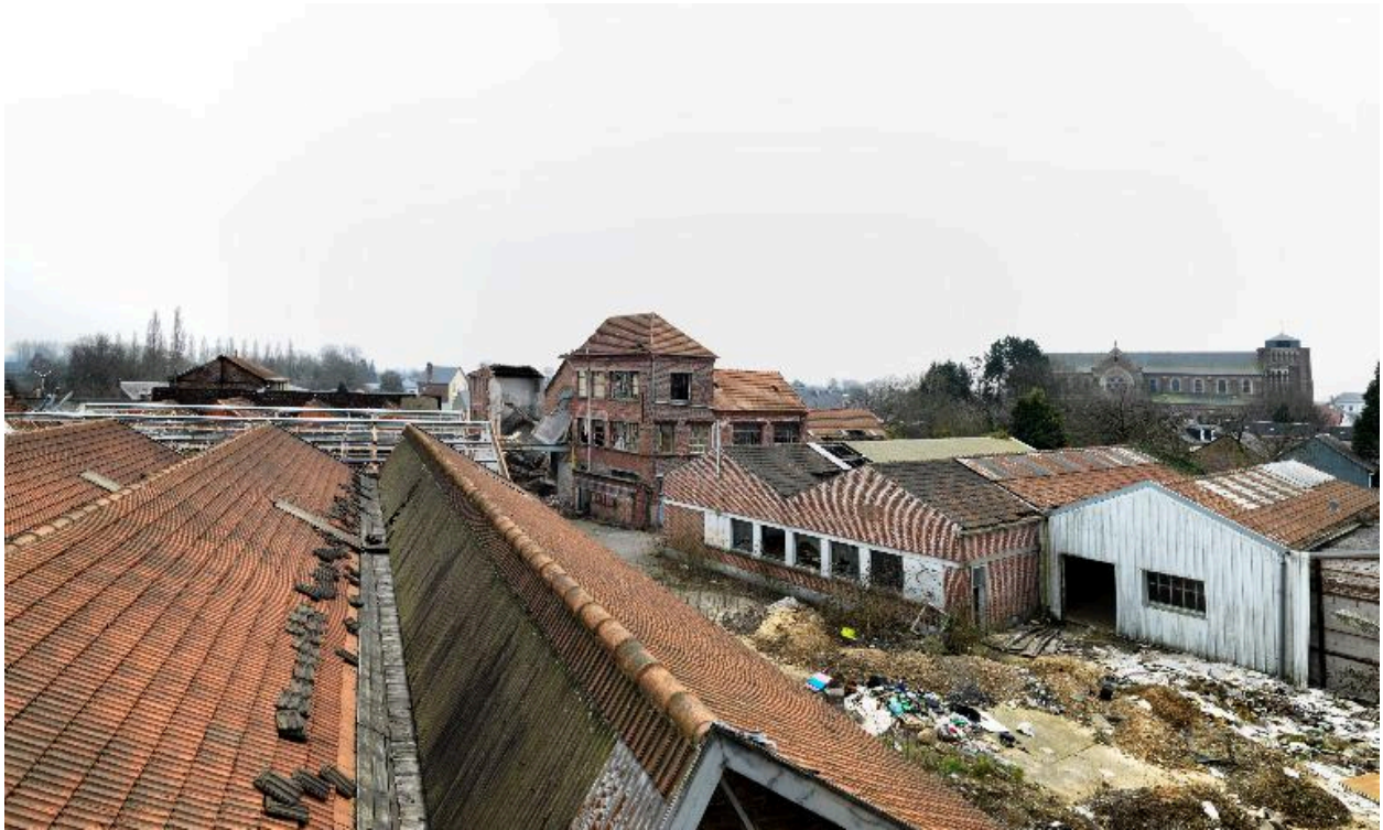
Vue d'ensemble de l'ouest du site industriel ; à l'arrière plan, l'église.
