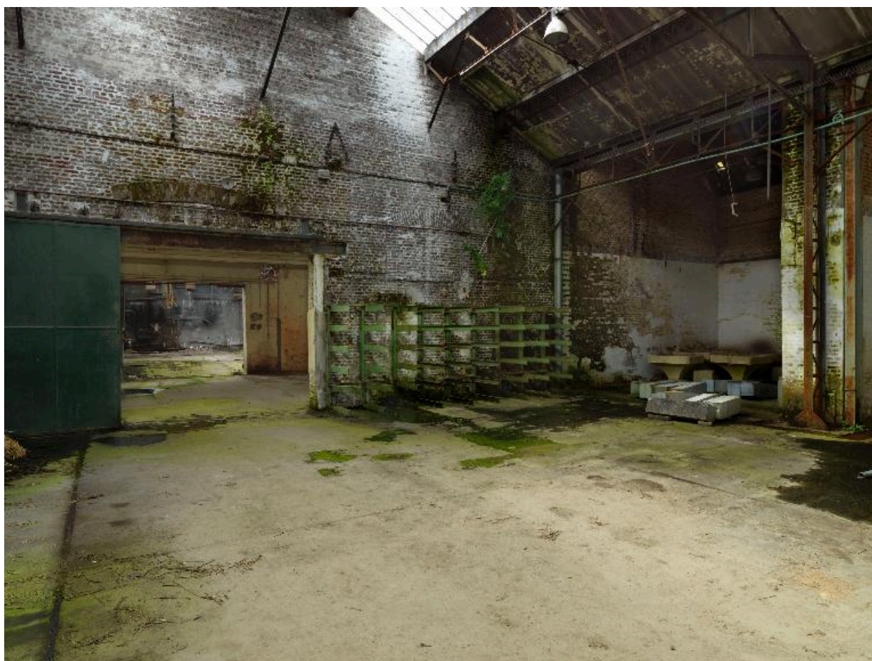
Vue intérieure des anciens entrepôts de stockage de matières premières.
