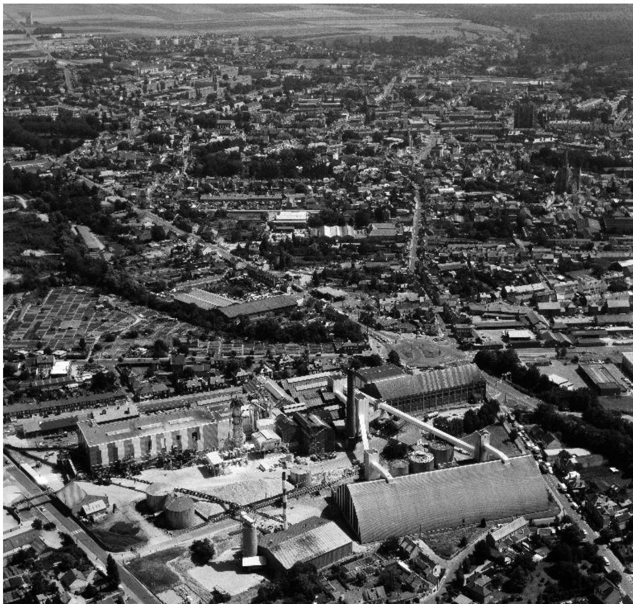
Vue aérienne de 1990, flanc nord.
