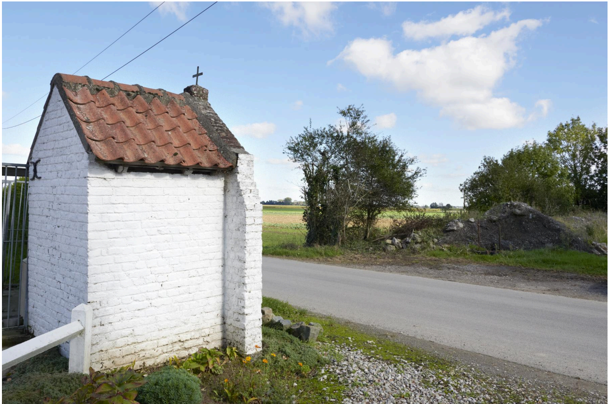
Vue arrière de la chapelle.
