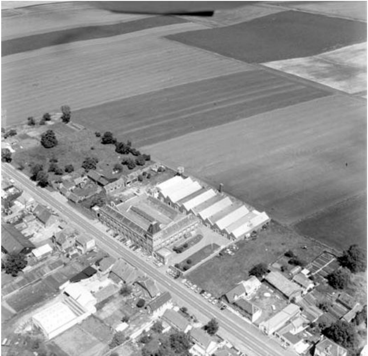
Vue aérienne, flanc sud-ouest.
