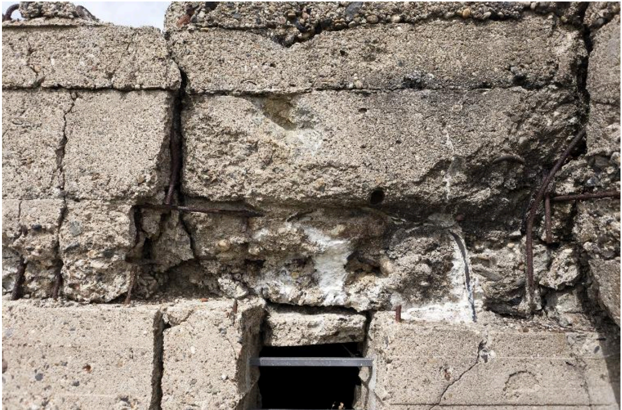
Casemate (f), détail du ferrailage
