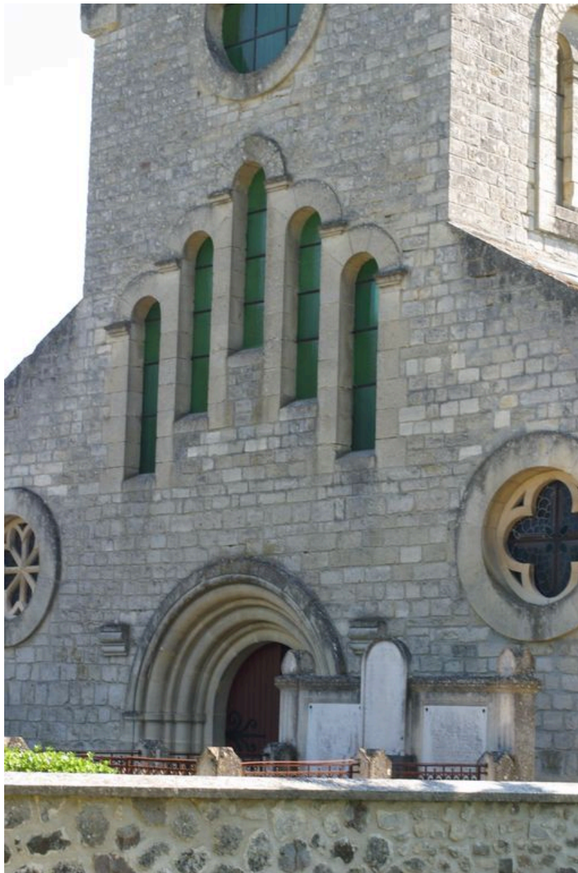
Vue partielle de la façade.
