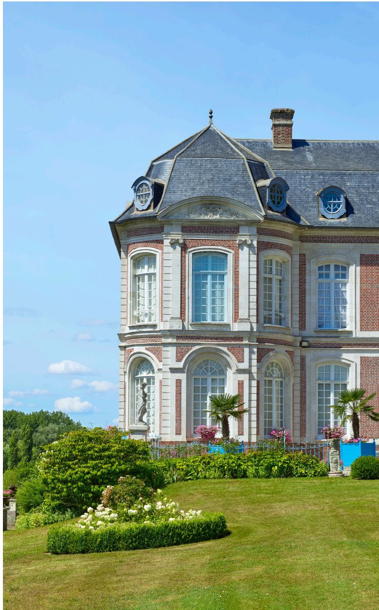
Façade sur jardin, pavillon sud, vue d'ensemble.
