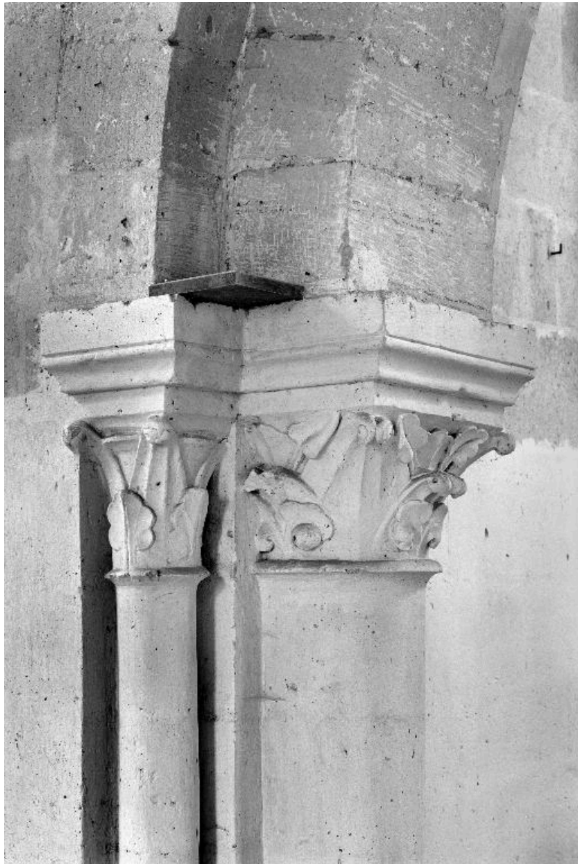
Chapiteaux des colonnes qui supportent un des arcs nord de la nef (près des fonts baptismaux).
