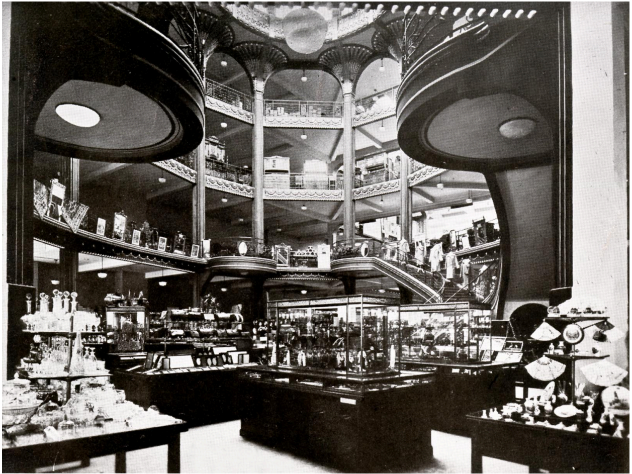
Vue intérieure des Nouvelles Galeries entre 1927 et 1934 (Cité de l'Architecture et du Patrimoine ; fonds des Bétons armés Hennebique : 3-D-364-f).
