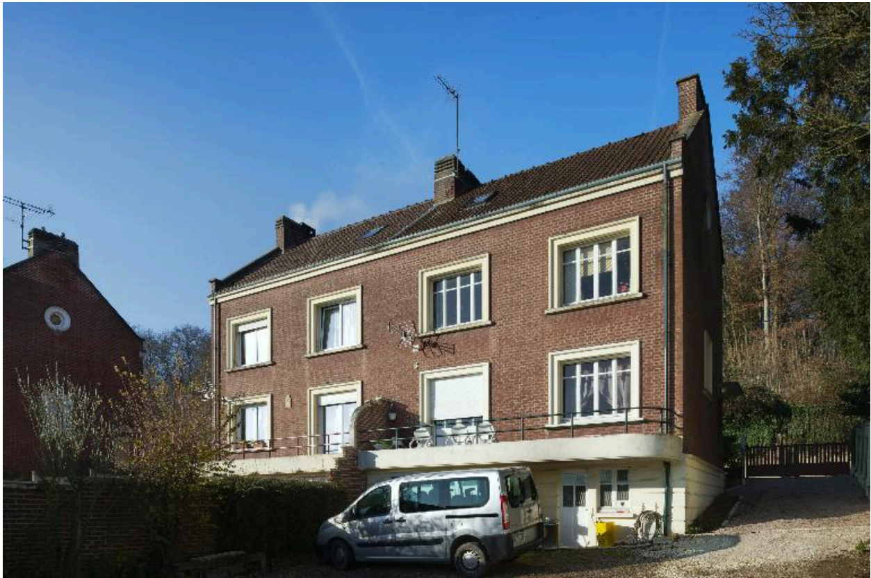
Façade postérieure d'une maison (55-57, rue Pierre-Legrand)
