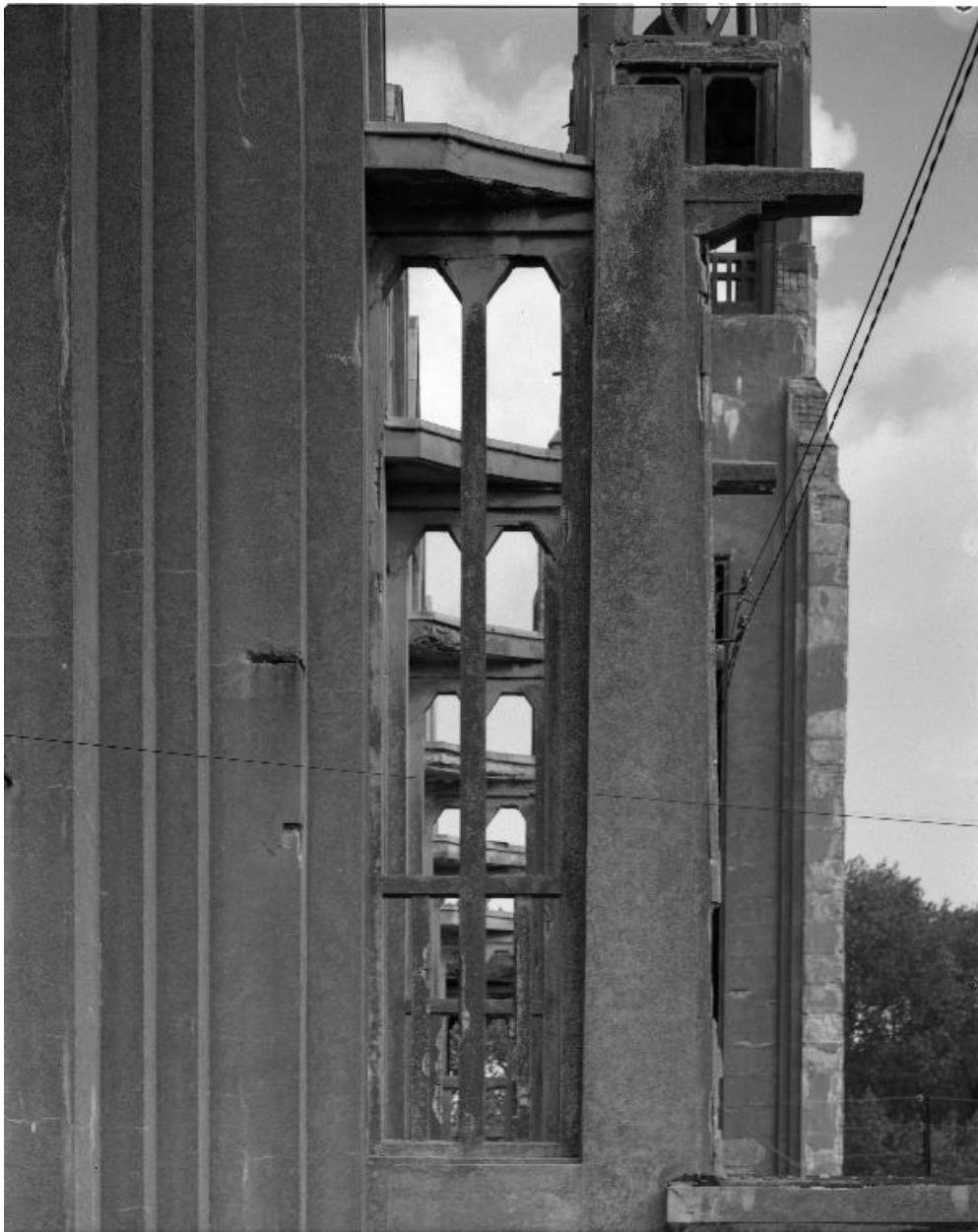
Façade Nord, détail : enfilade des culées d'arcs boutants.
