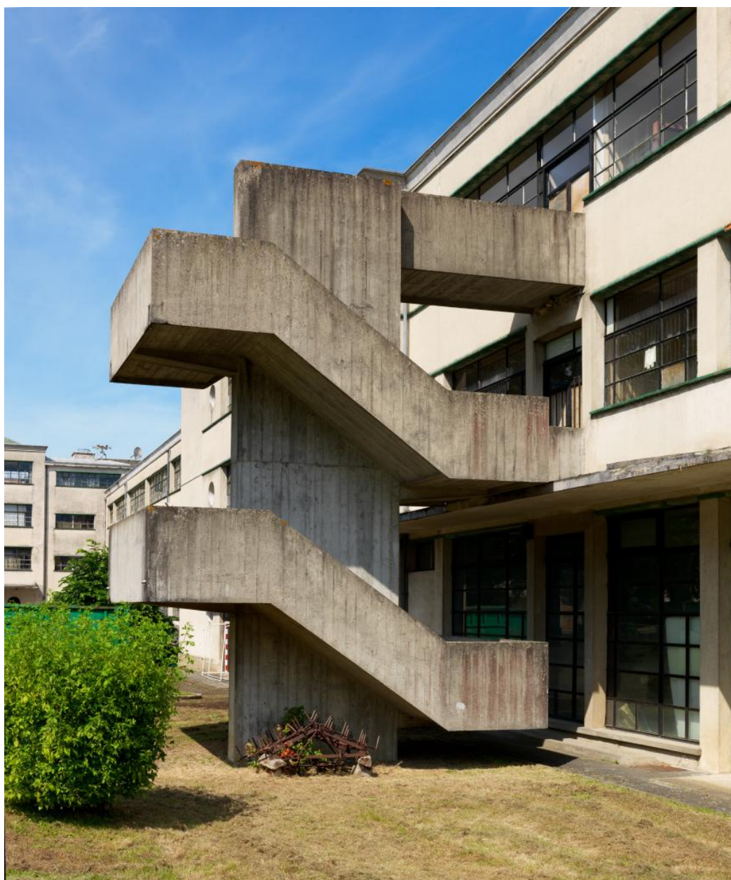
Détail de l'escalier hors-œuvre en béton armé.
