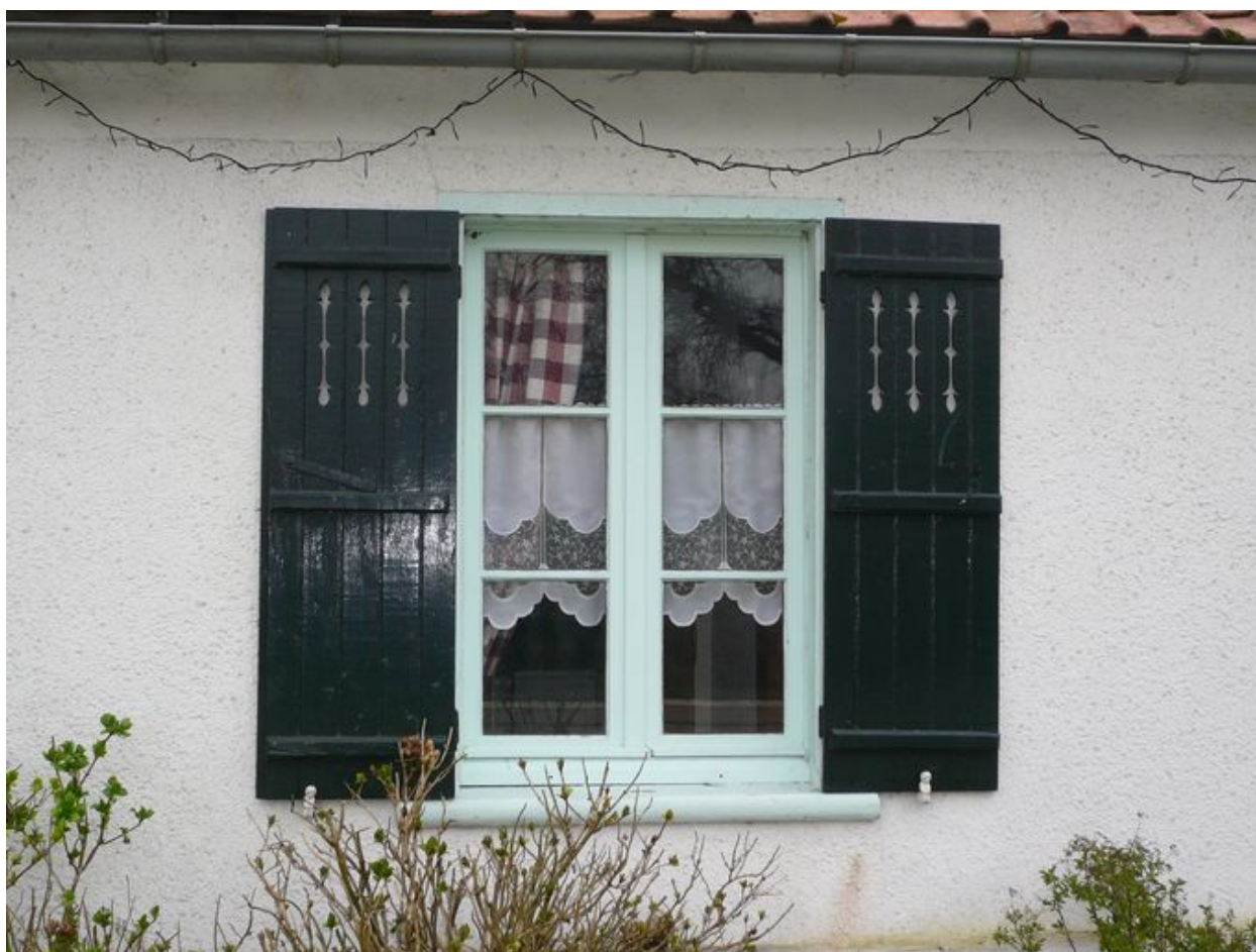
Vue détaillée d'un des contrevents.
