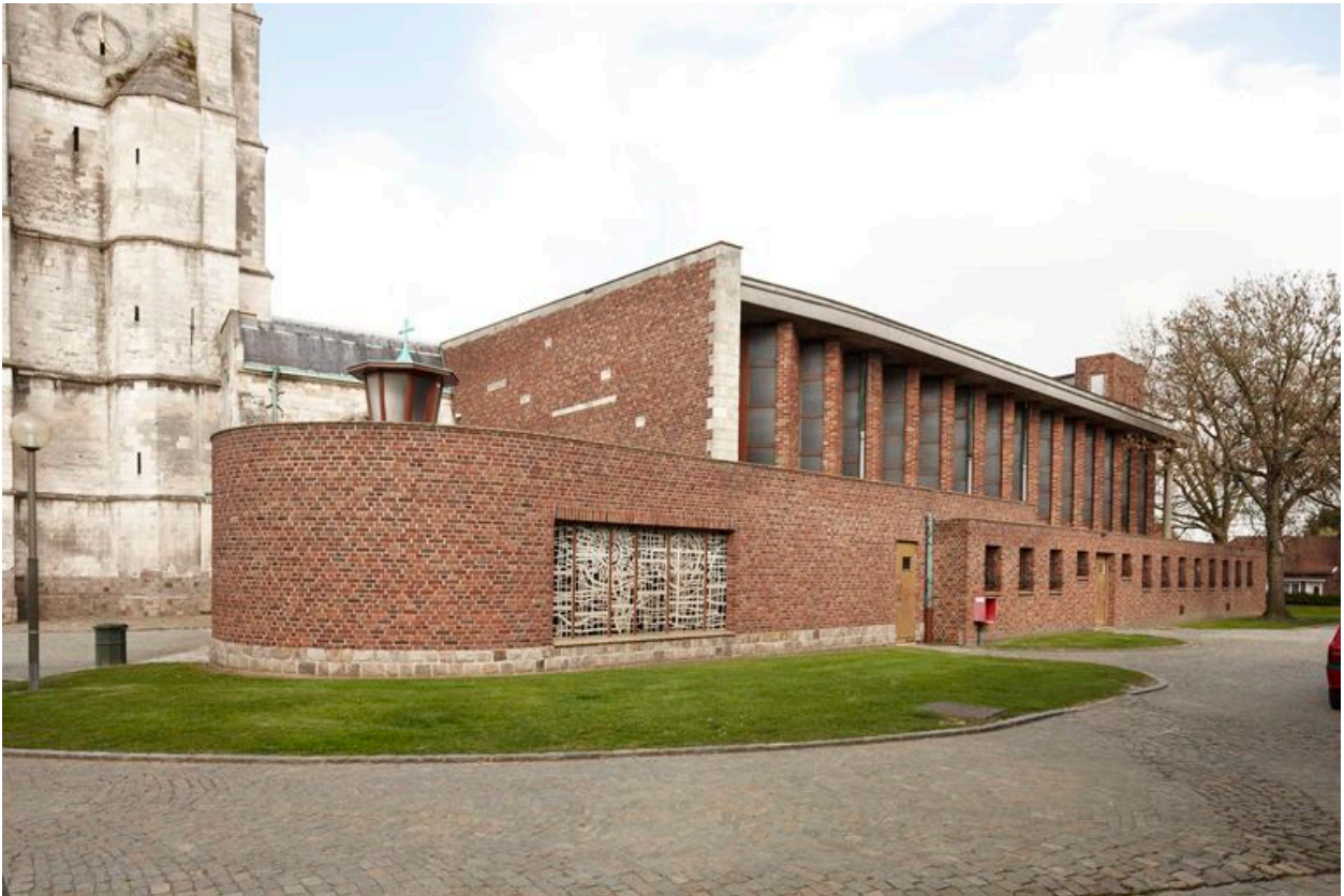
Vue générale avec le baptistère au premier plan.
