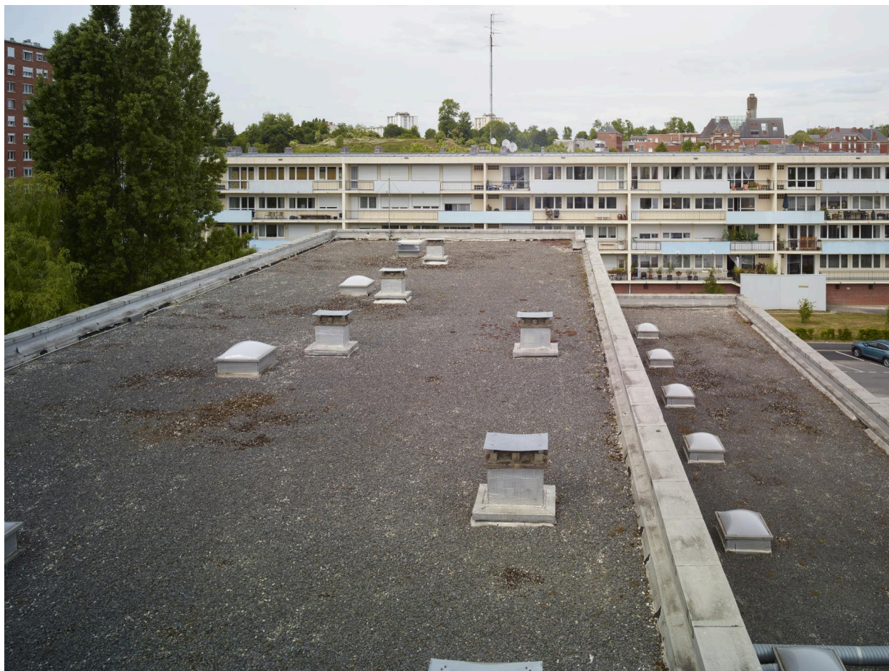
Vue du toit-terrasse.
