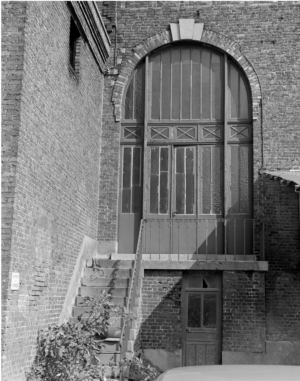
Salle des machines, entrée.
