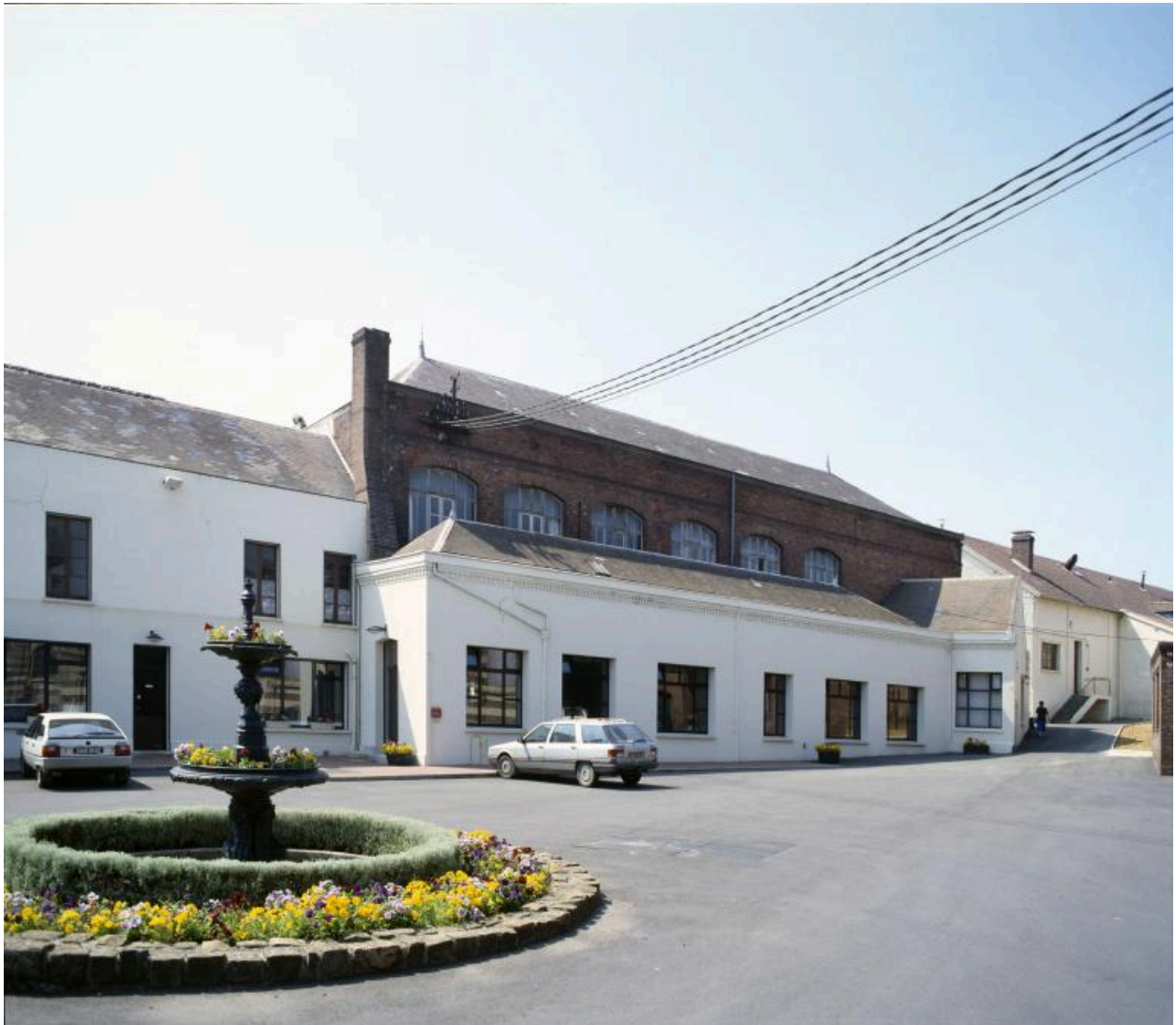
Vue des façades sur cour des bâtiments administratifs.
