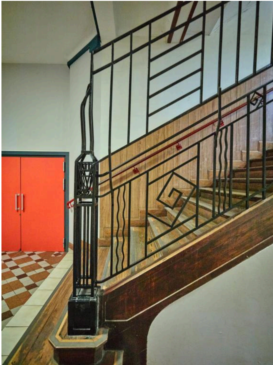
Vue intérieure de l'escalier principal qui dessert les salles de classe : départ de la rampe.
