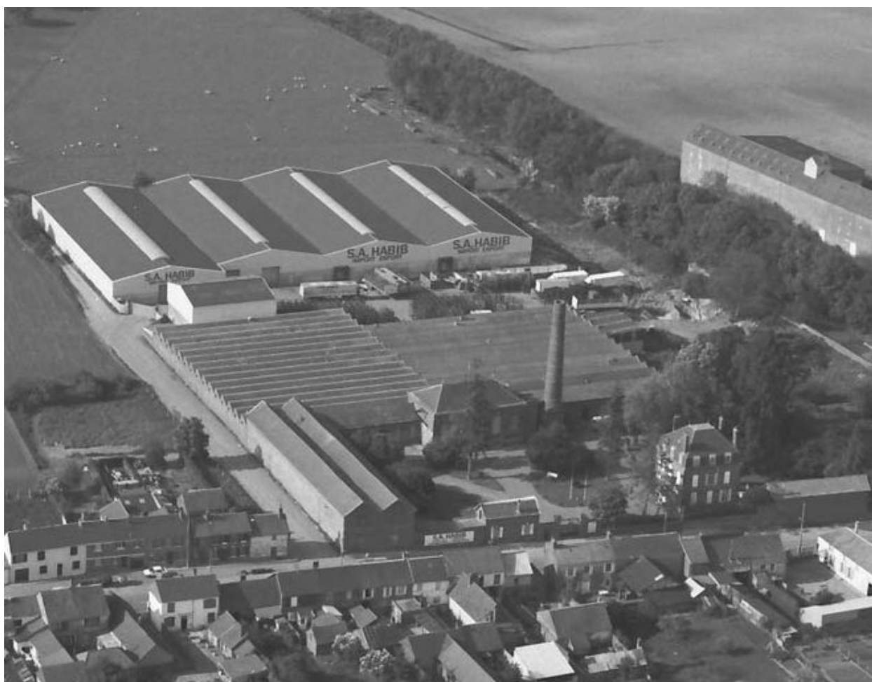
Vue aérienne de l'usine en 1994.
