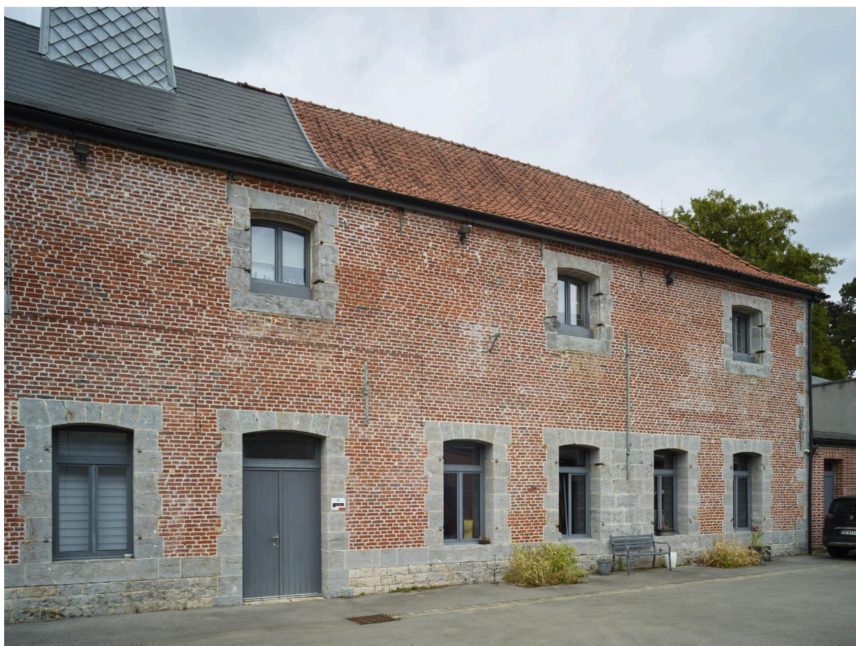
Ancienne boulangerie militaire : extrémité est de la façade sur cour.
