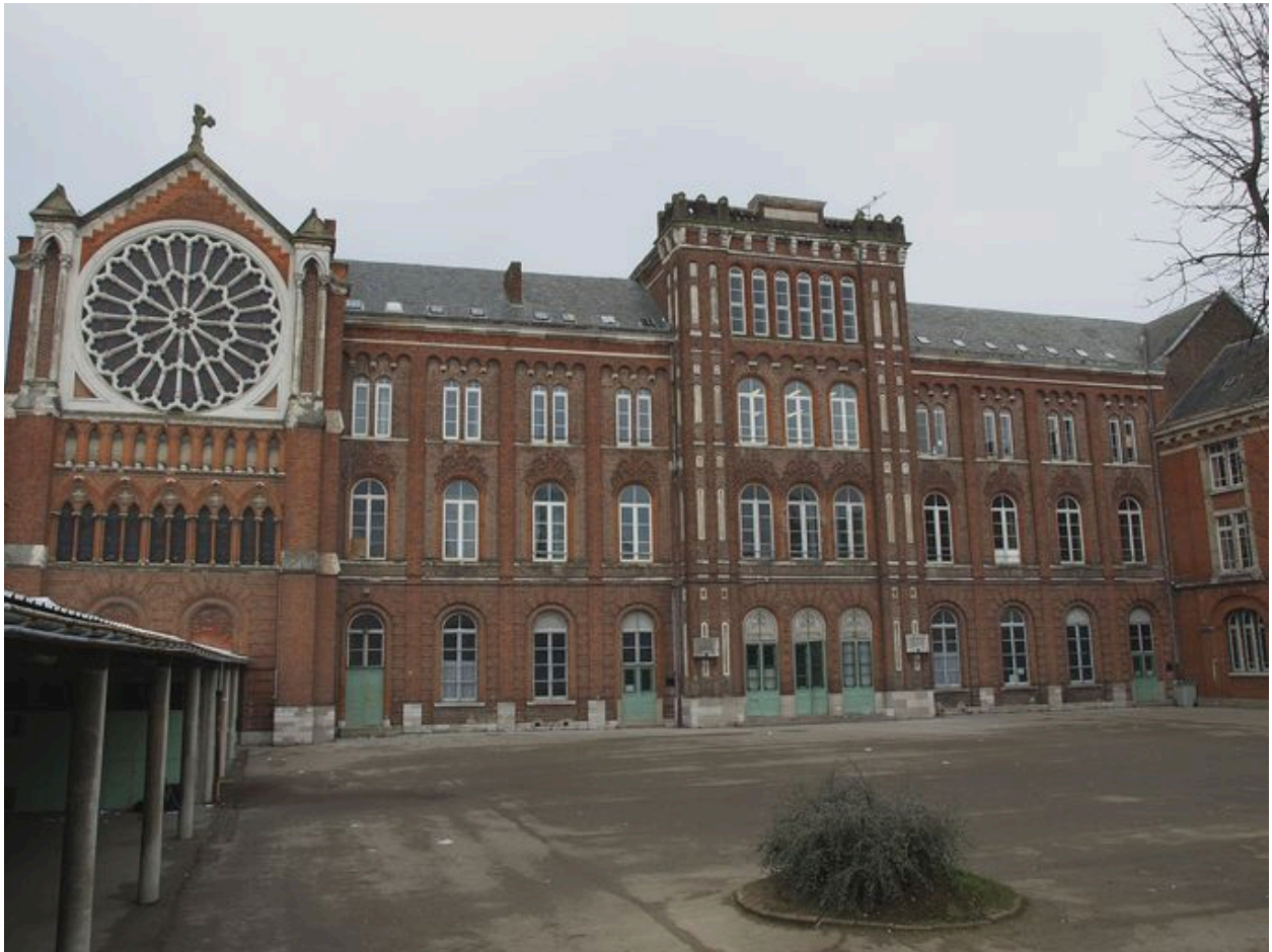
Façade sur cour : vue générale
