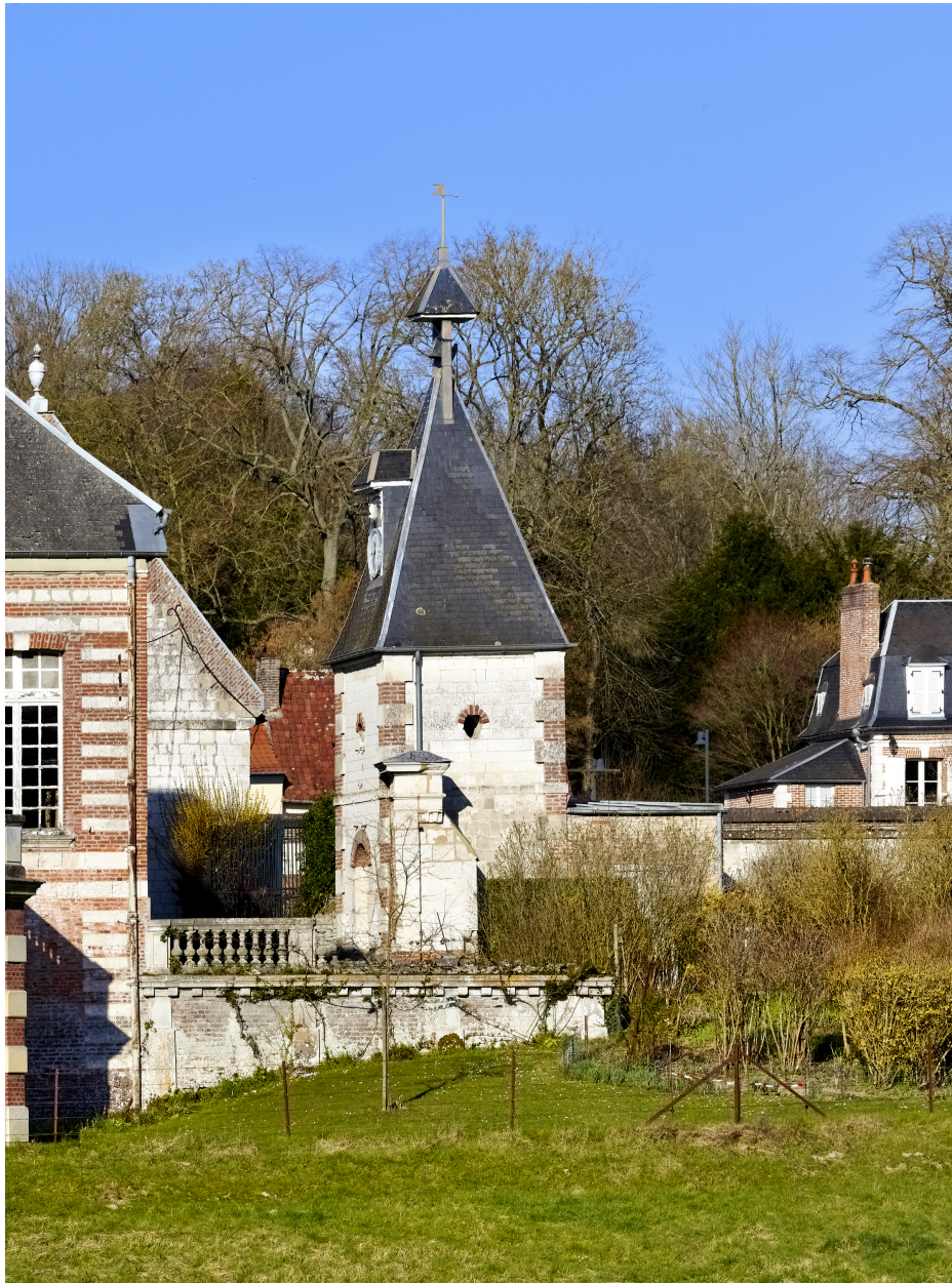
Vue du pigeonnier, depuis le sud.
