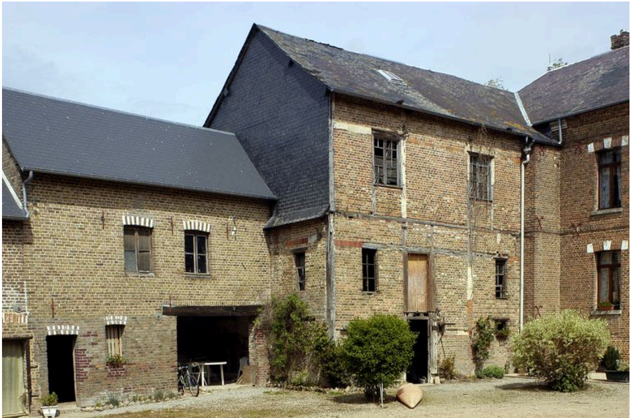
Façade sur cour du moulin.
