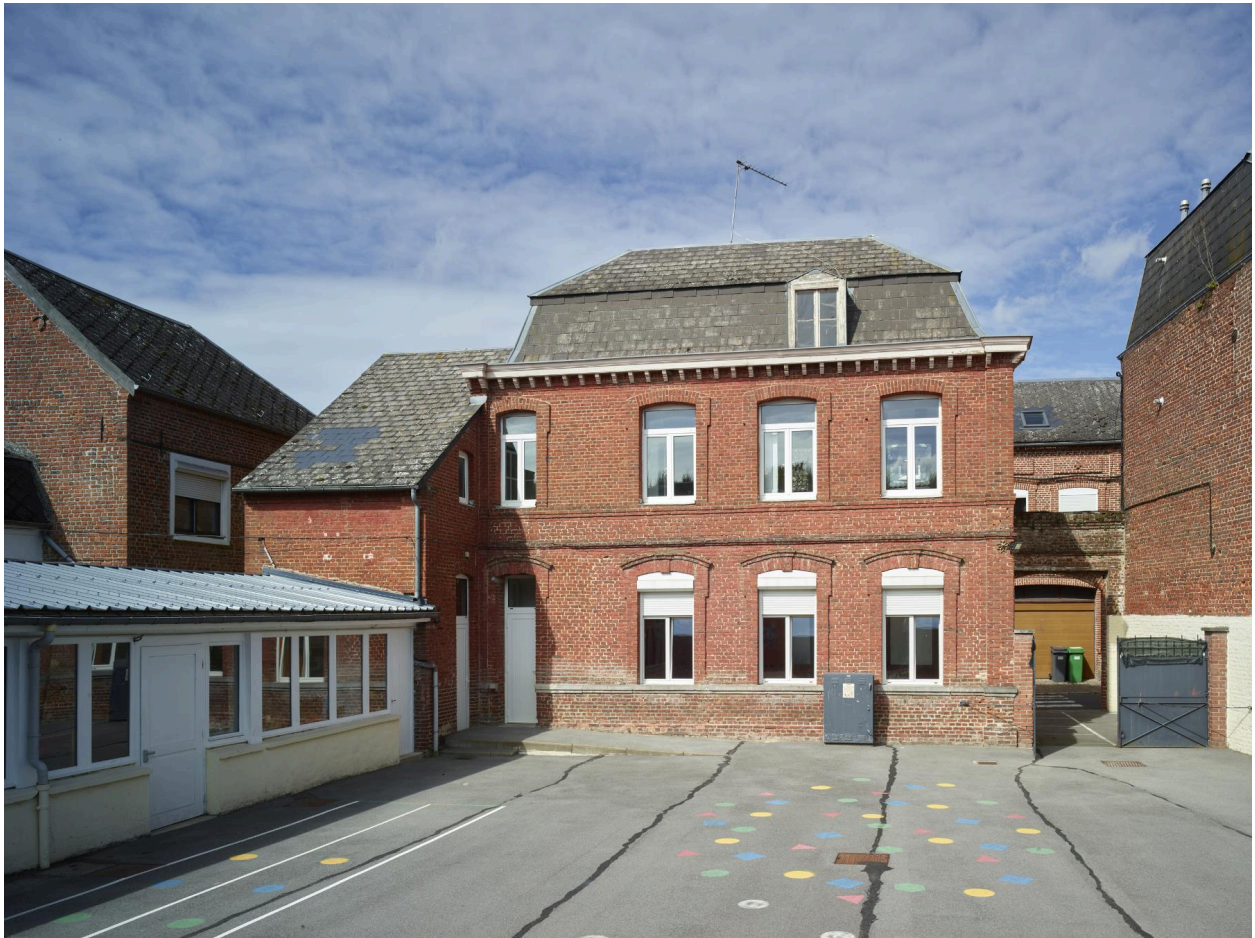
École maternelle du Centre : vue de la façade sur cour de la partie "ancienne salle d'asile" et de la face arrière du portail d'accès à la cour.
