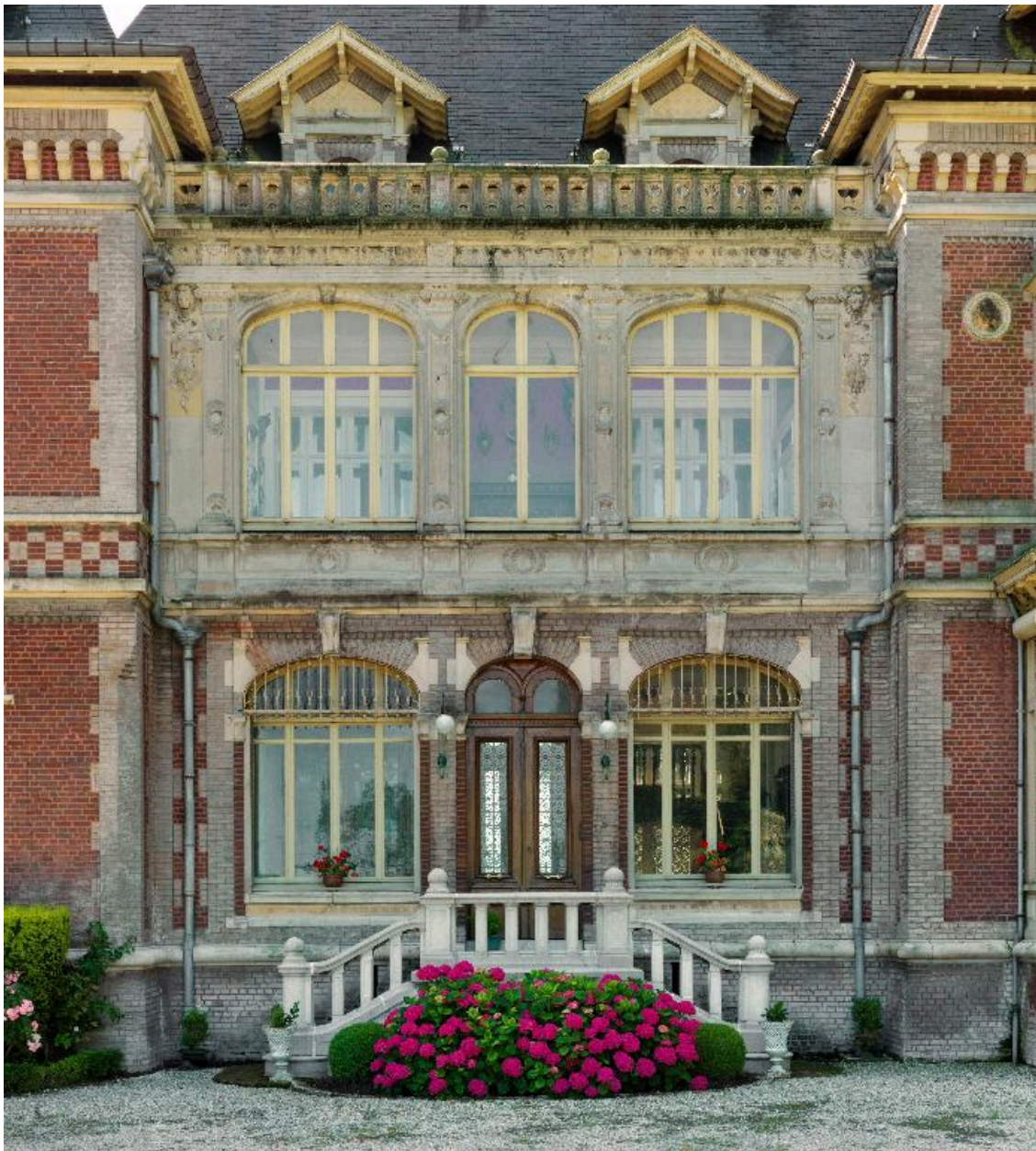
Détail de la façade principale.
