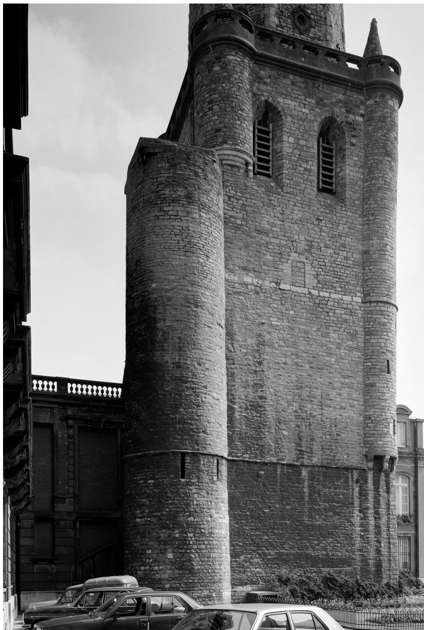
Façade sur place de la Résistance, partie inférieure : détail.
