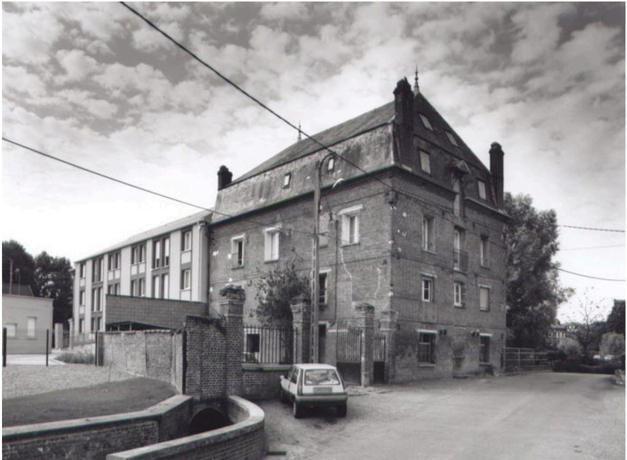
Vue d'ensemble de la minoterie vers la rue du Moulin.
