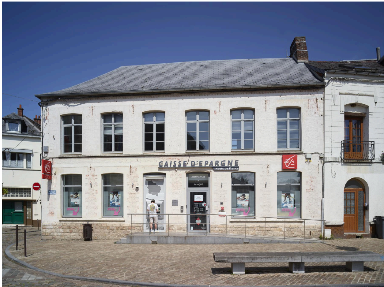
Maison de maître - 24, place du général Leclerc.
