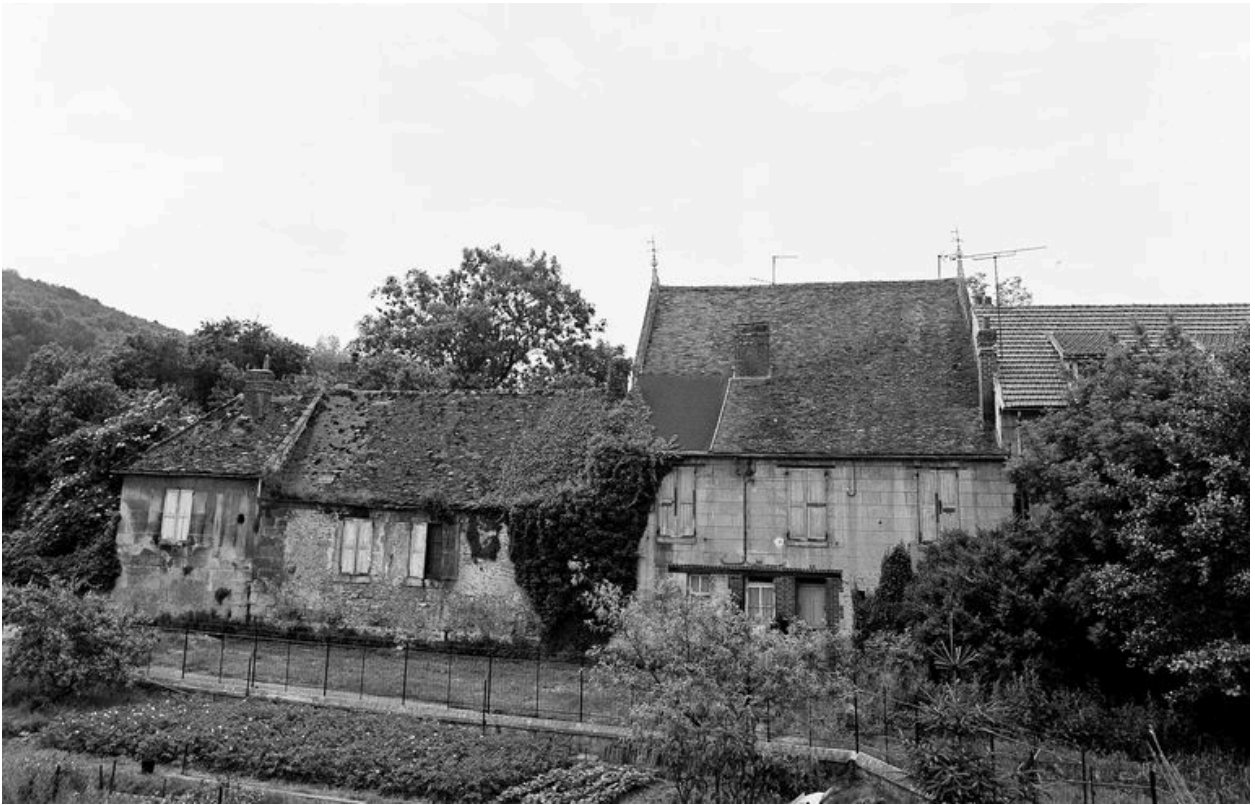
Vue générale, côté nord.
