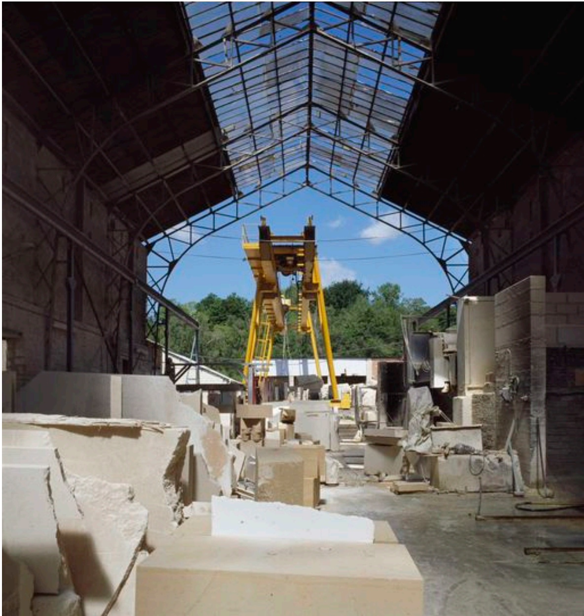
Vue générale de l'atelier de sciage (carrière Ouachée-Corpechot, Saint-Maximin).
