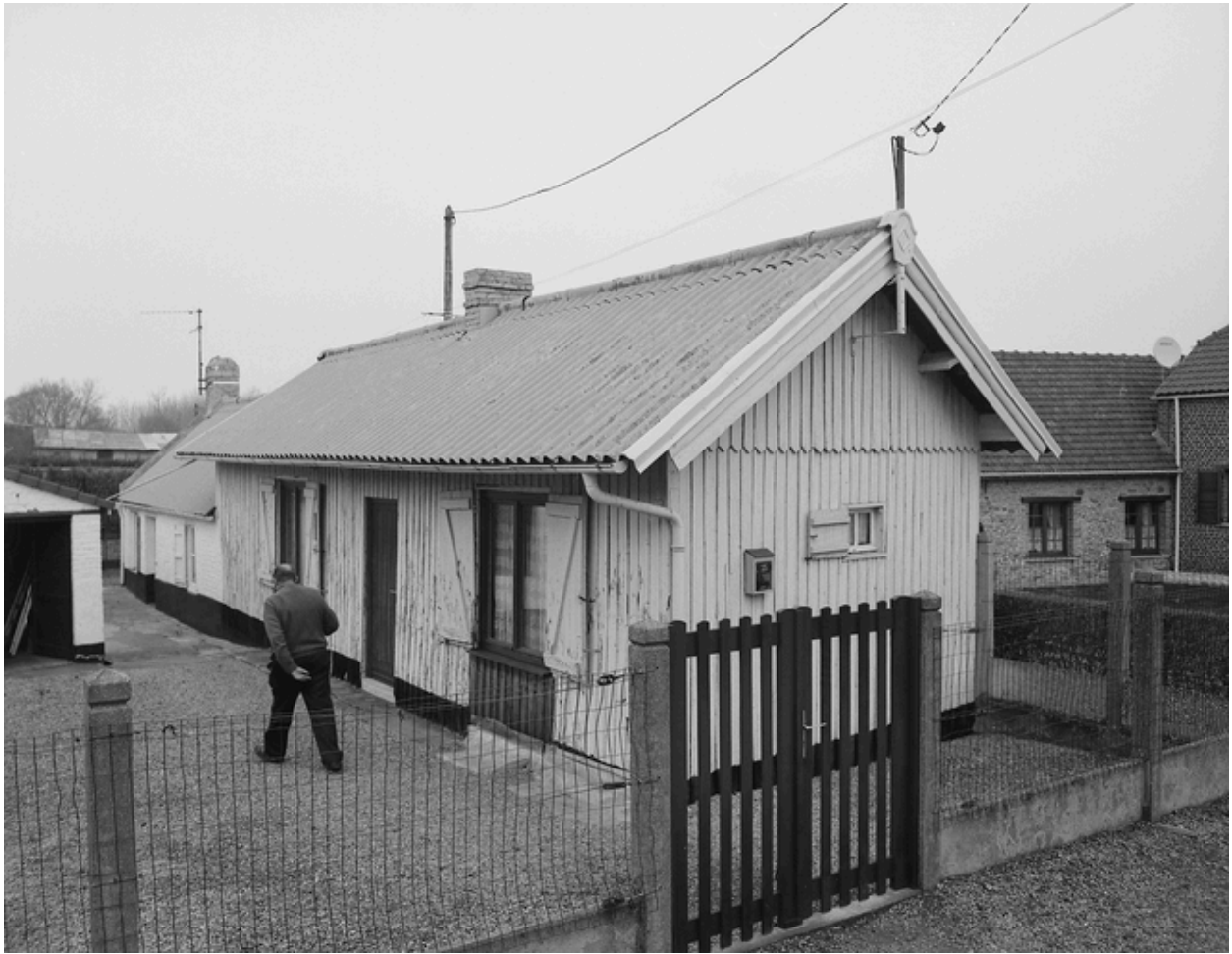
Vue générale de la maison en bois.
