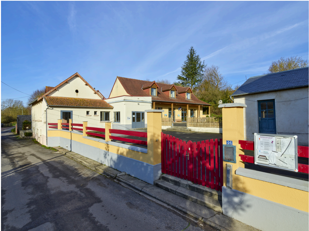
Nouveaux bâtiments de l'école.
