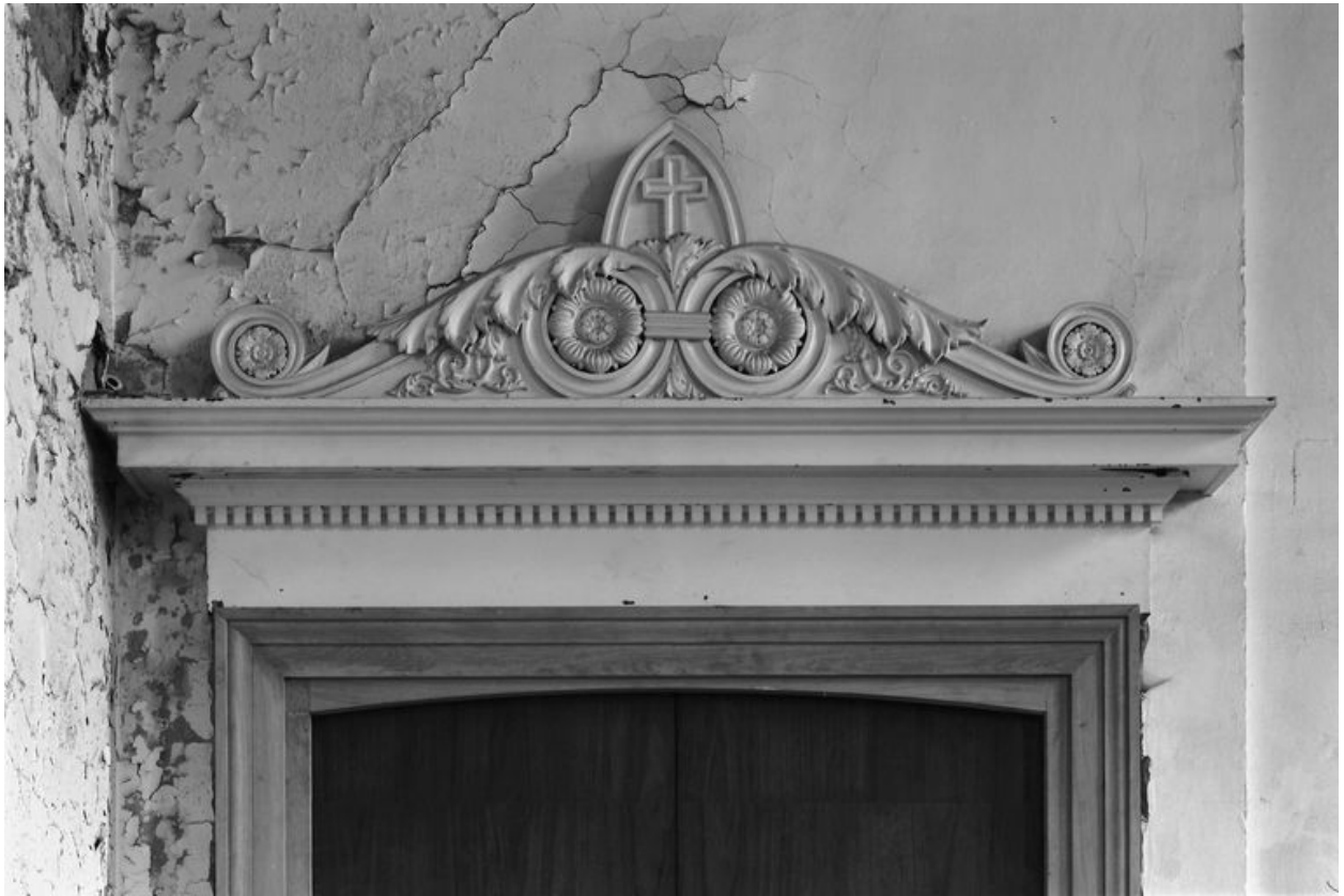
Chapelle, vue intérieure. Détail sur le dessus de porte du mur est de la nef, en 1984.
