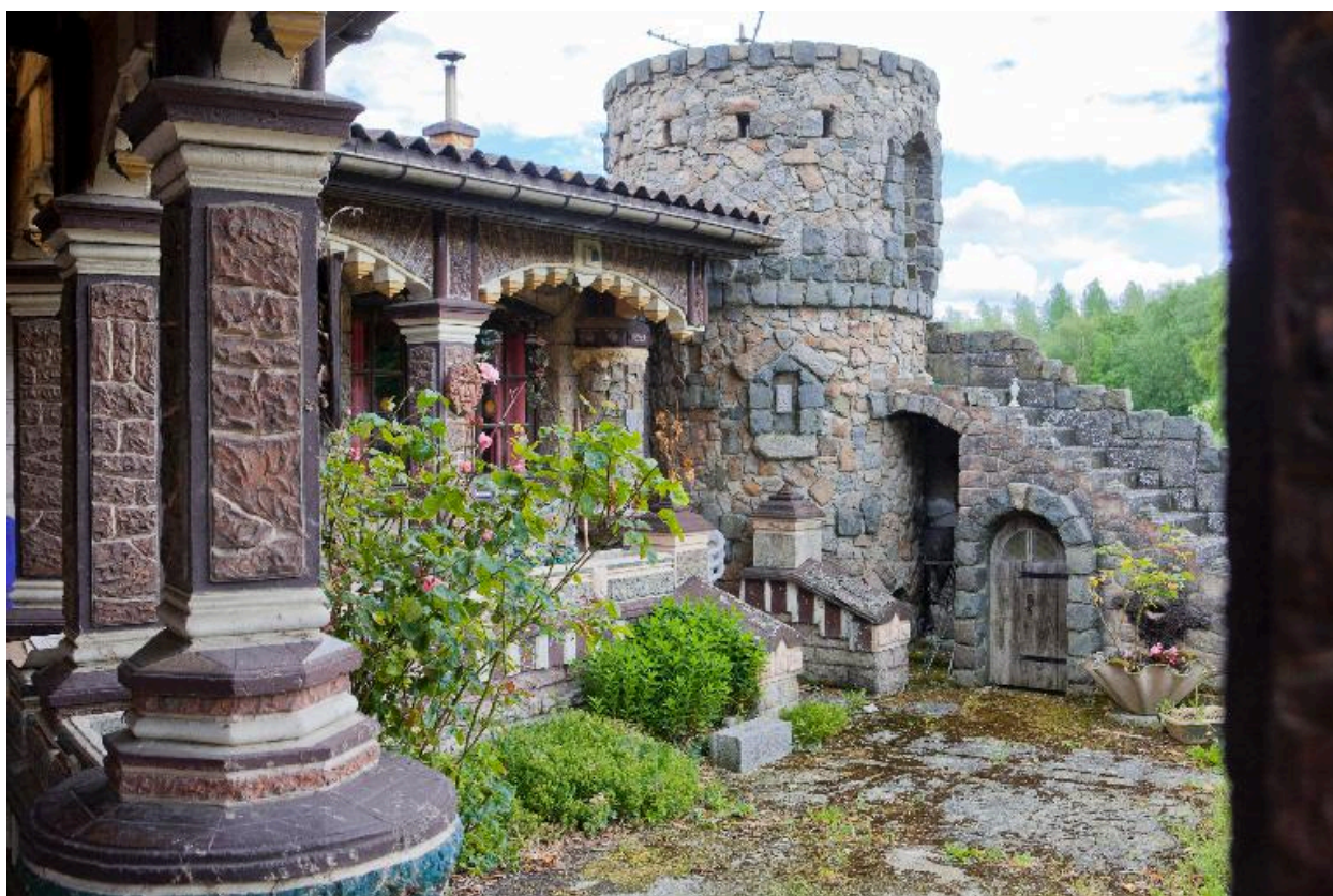
Vue générale depuis l'entrée.
