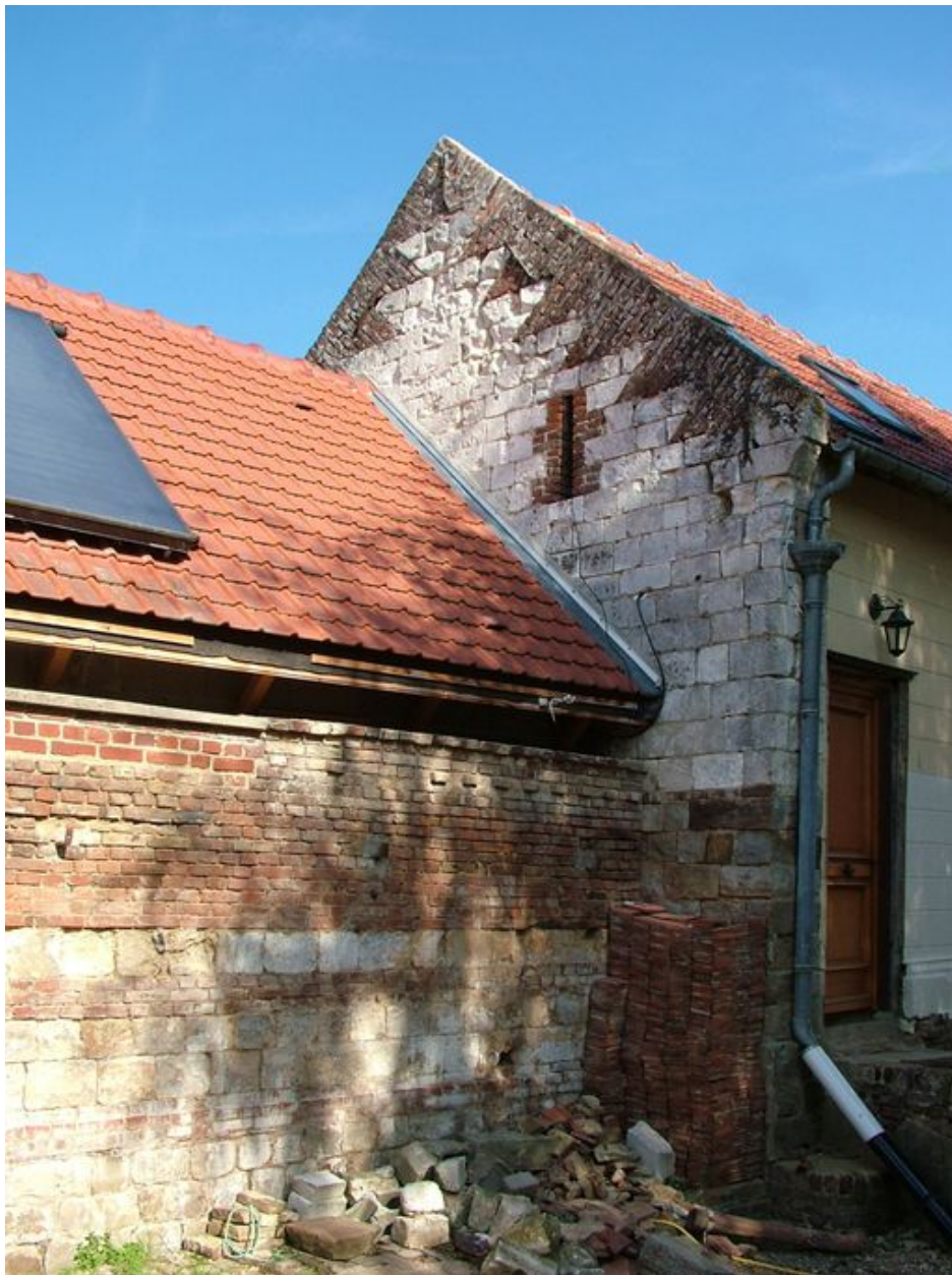
Vue partielle du pignon ouest du logis et du mur d'un bâtiment disparu.
