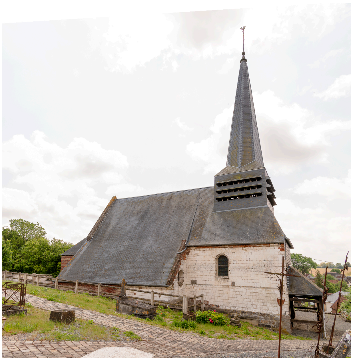
Église, vue depuis le cimetière côté nord.
