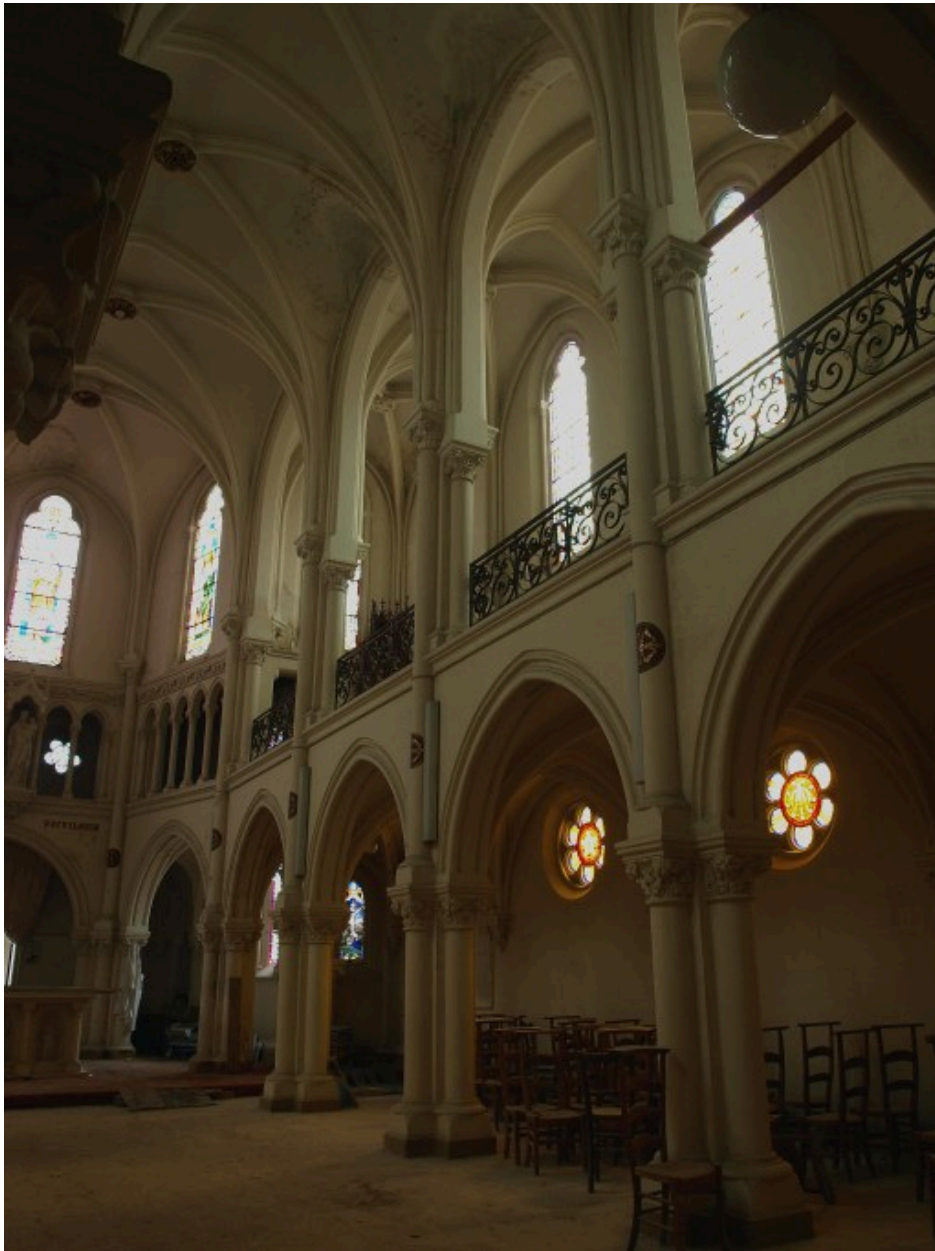
Vue générale : baies hexalobées de la nef
