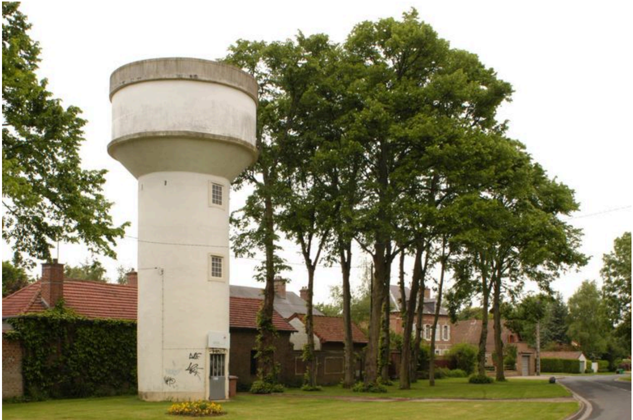
Le château d'eau.
