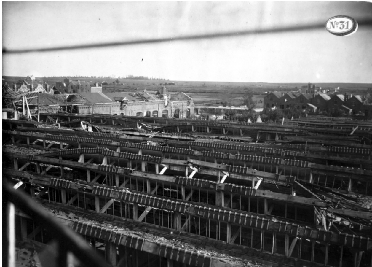
Vue générale des toits des ateliers en direction du sud-est, vers 1919 (AD Aisne).
