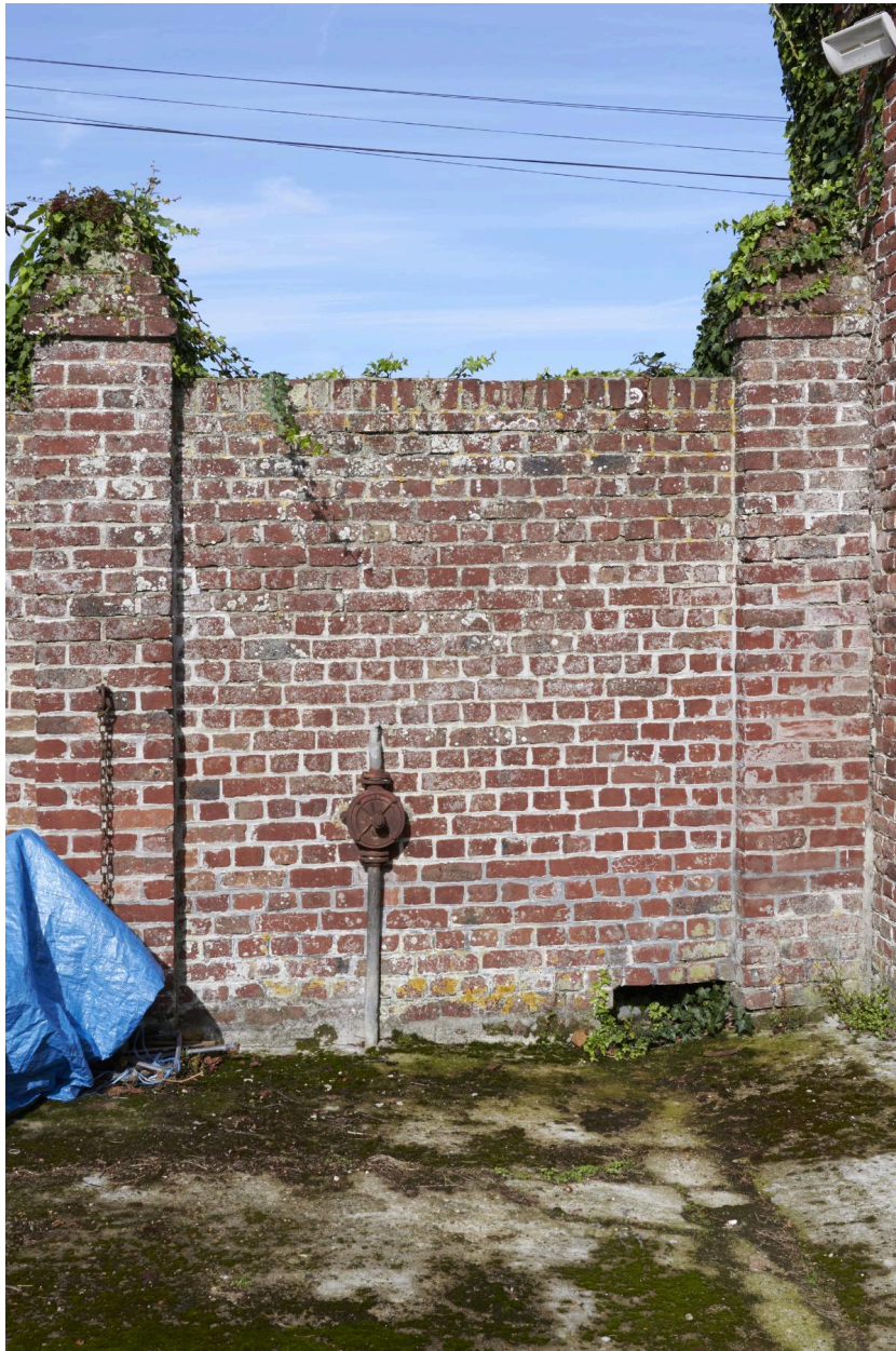
Détail du mur de clôture.
