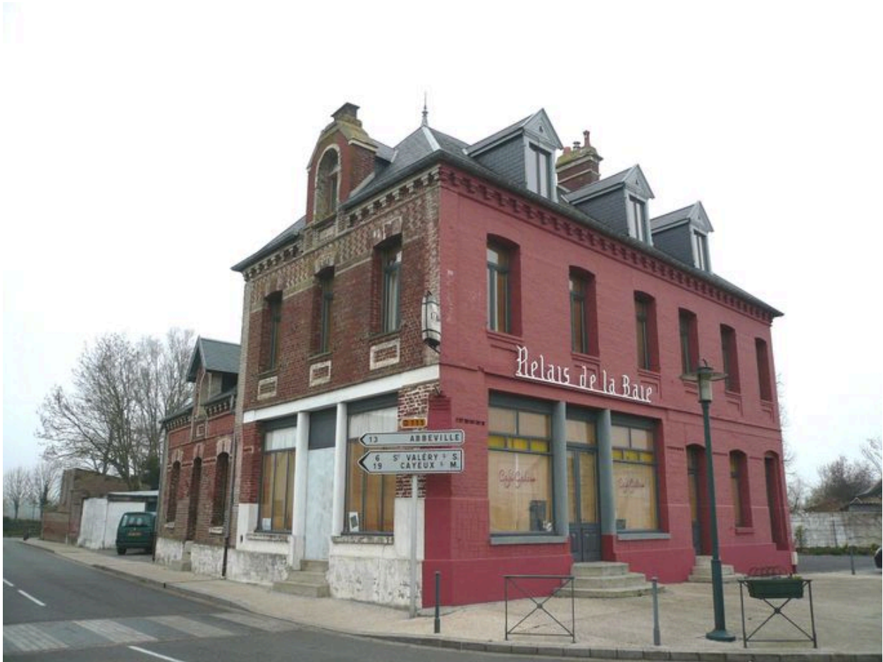
Vue de face de l'ancienne partie hôtel.
