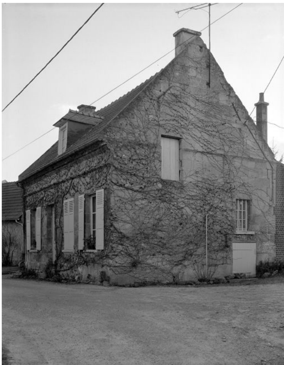
Logis. Vue générale.
